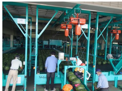
(更新された設備の一部)
