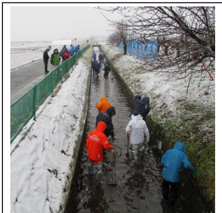
(水路清掃の様子)
