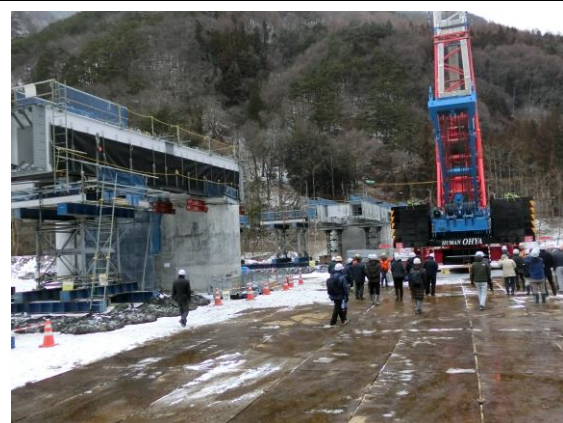
(工事中の八景山大橋)
