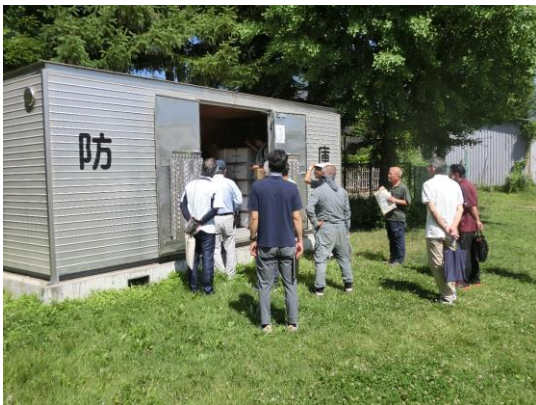
(防災倉庫内の確認)
